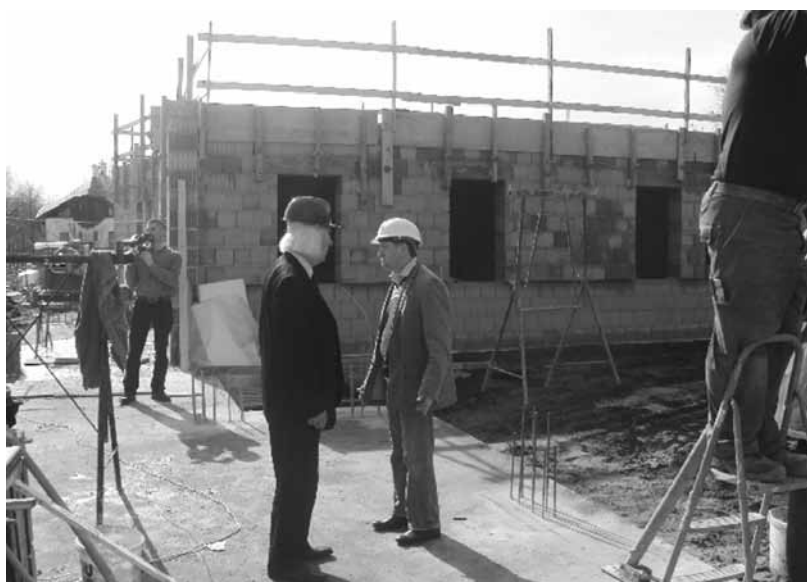
Terepszemle az épülő új szárnyban
